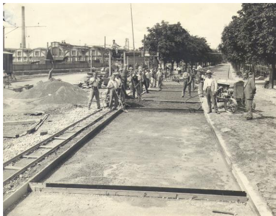
Bild: Bahnhofstrasse Arbon, Einbau Betonbelag 1928 (Foto: Archiv ehem. Betonstrassen AG)
